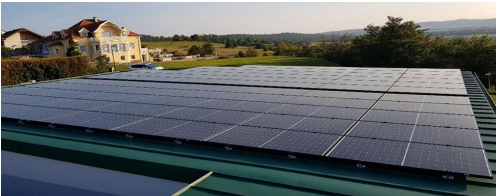
Die PV-Anlage am Hochbehälter liefert seit einigen Monaten bereits klimaneutralen Strom für den Betrieb der Brunnenpumpen und der Aufbereitungsanlage. **Bisher wurden über 7.000 kWh Sonnen-Strom erzeugt.**
